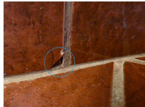
Sprekk/knekt flis
