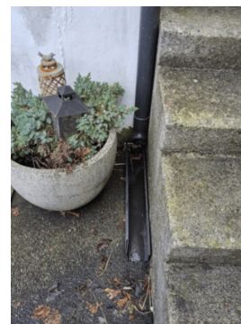
Mangelfull bortledning av vann fra taknedløp
