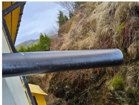
Mangelfull bortledning av vann fra taknedløp
