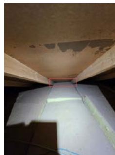
Begrenset ventilering av konstruksjon
