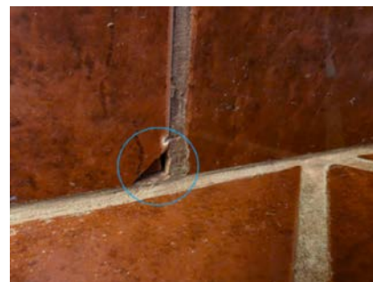
Sprekk/knekt flis
