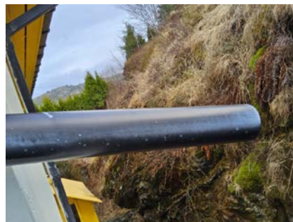
Mangelfull bortledning av vann fra taknedløp
