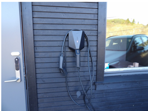
Billader ved inngangsparti.
