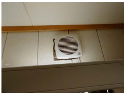
Ikke tett rundt mekanisk vifte.
