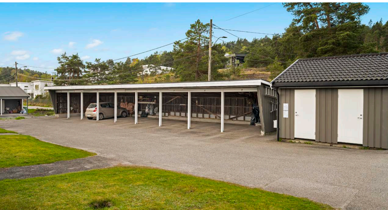
Carporter i borettslaget deles etter venteliste (pt. ingen på liste, så neste eier kan overta). Utv. sportsbod v/ carport
