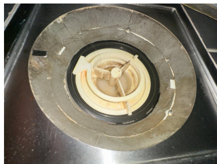
Plastsluk med klemring for membran
