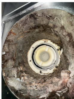
Plastsluk med klemring for membran
