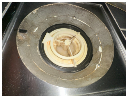
Plastsluk med klemring for membran
