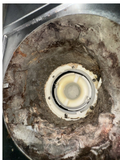
Plastsluk med klemring for membran
