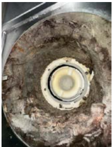
Plastsluk med klemring for membran
