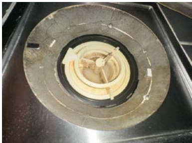
Plastsluk med klemring for membran
