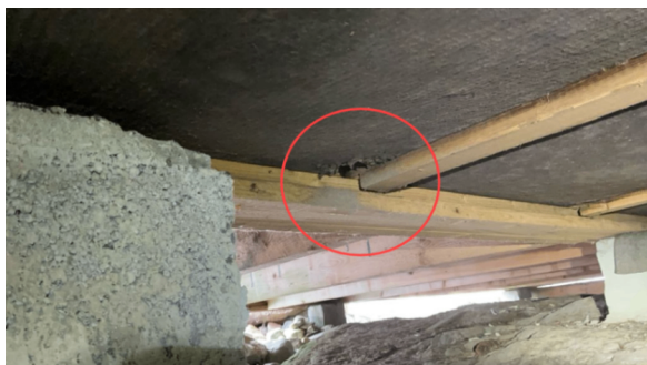
Utettheter i stubbeloft enkelte steder.
