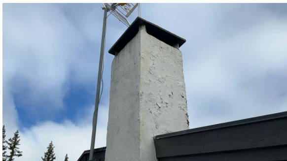
Malingsflass på pipe.
