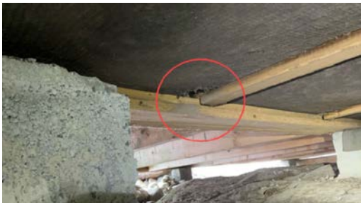
Utettheter i stubbeloft enkelte steder.
