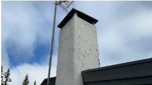
Malingsflass på pipe.
