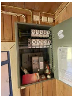
Synlig avvik på ledninger, brytere og stikk
