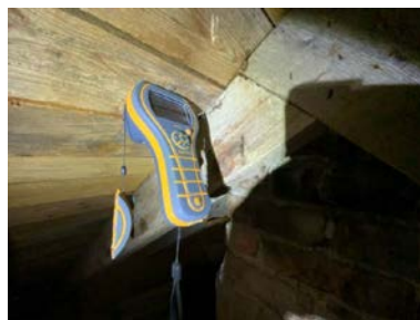
Ved enkel fuktmåling registrerte jeg tørre verdier.
