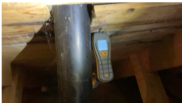
Fuktmåling ved lufterør uten avvik.
