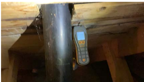
Fuktmåling ved lufterør uten avvik.
