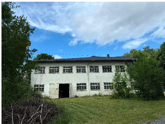
Sørsiden, opprinnelig del
