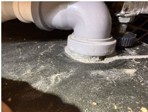
Avløp fra dusjkabinettet
