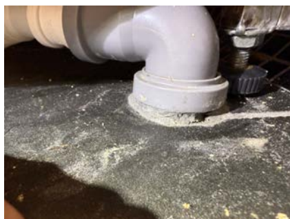
Avløp fra dusjkabinettet
