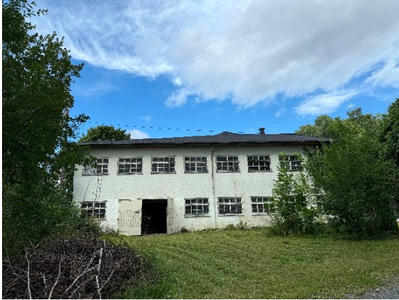
Sørsiden, opprinnelig del
