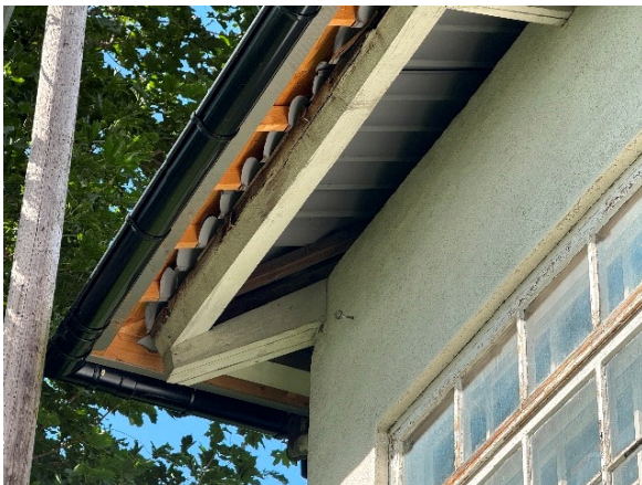
Taktekking etablert opp på opprinnelig tak på eldste del
