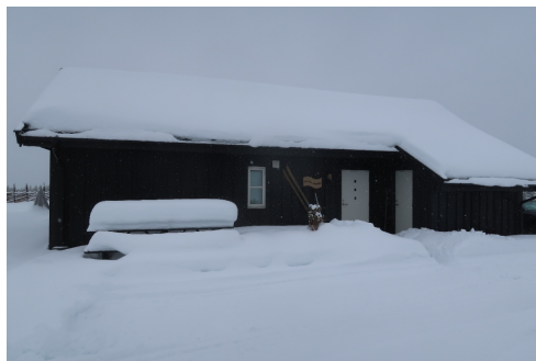
Snødekket terrasse ved inngang (ikke oppmålt)
