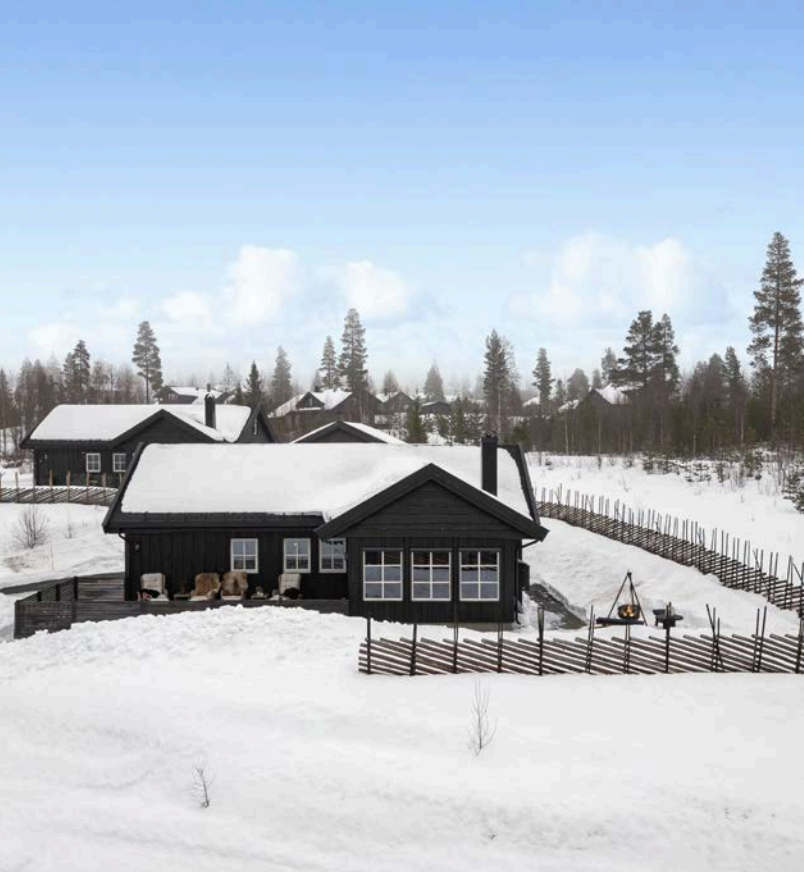
Eiendommen er dels inngjerdet med skigard, som ble satt opp i 2025. Det er også montert screens på stuevindue og verandadør på utbygget.
