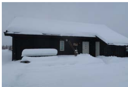
Snødekket terrasse ved inngang (ikke oppmålt)
