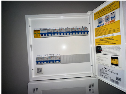
Sikringskap med automatsikringer.
