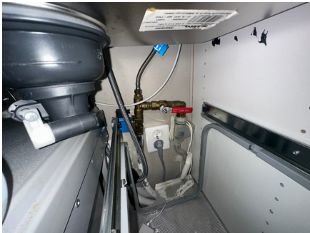
Røropplegg i kjøkkenbenk med Waterguard
