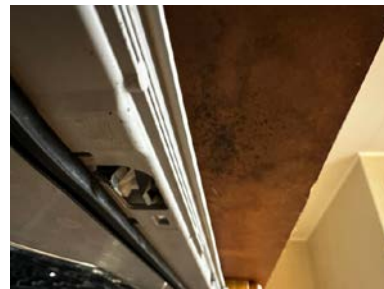
Svertesopp under benkeplate
