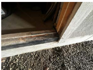
Dørterskel til teknisk rom
