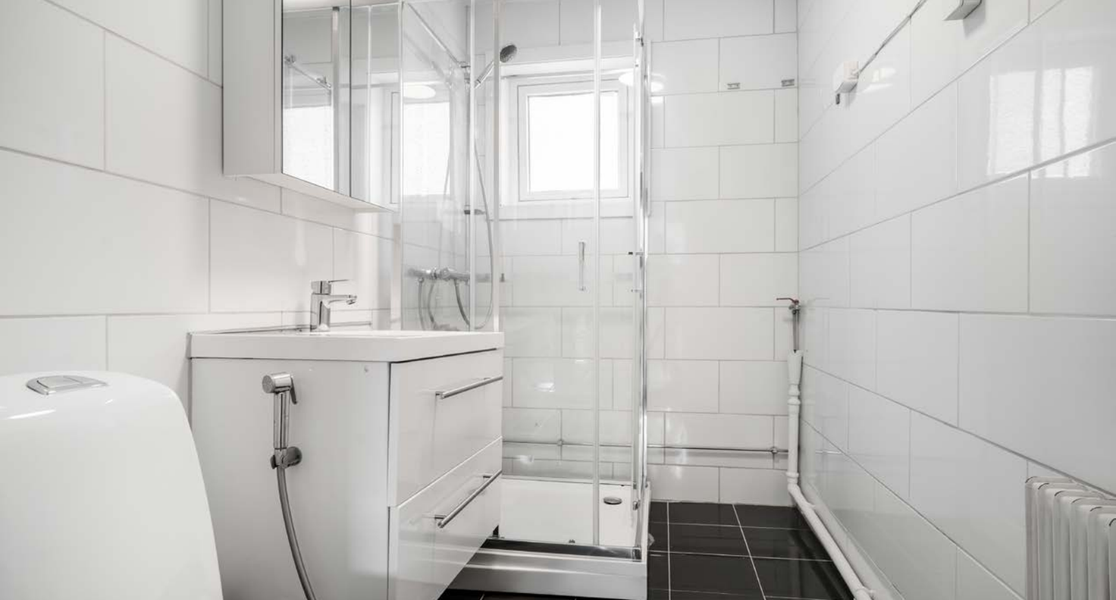
Flislagt baderom innredet med klosett, helservant på skuffeseksjon og dusjkabinett.
