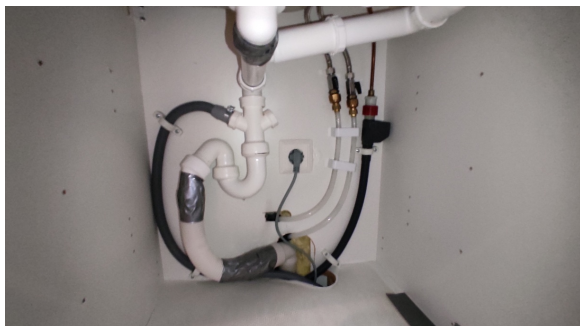
Kontroll av røropplegg.
