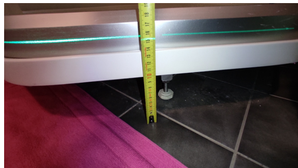
Kontroll av fallforhold.
