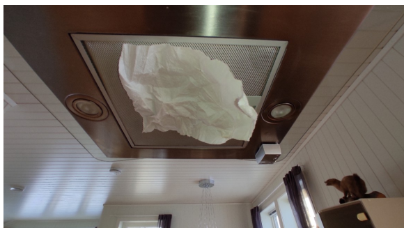
Test av avtrekket
