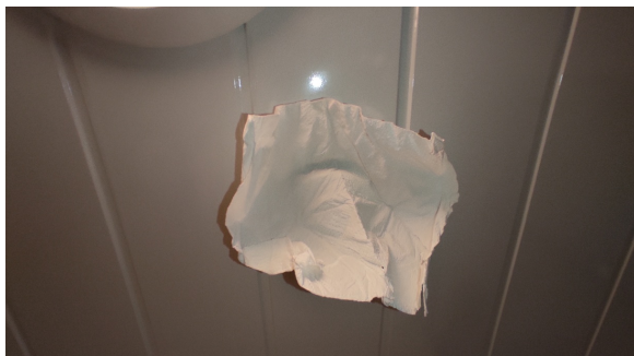
Test av avtrekket.
