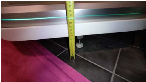
Kontroll av fallforhold.
