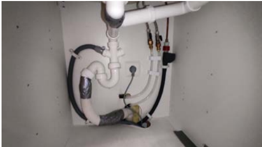
Kontroll av røropplegg.
