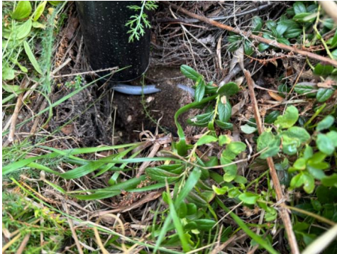
avløp avsluttet over terreng.
