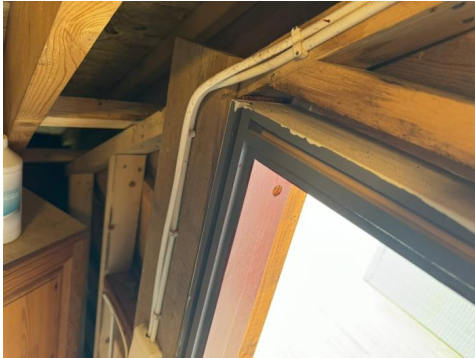
Eksempel på løs ledning.
