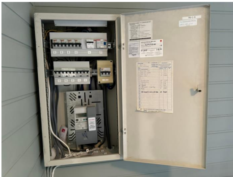
Eksempel på løs ledning.
