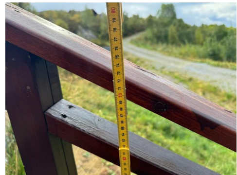
Rekkverkshøyde i trappen.
