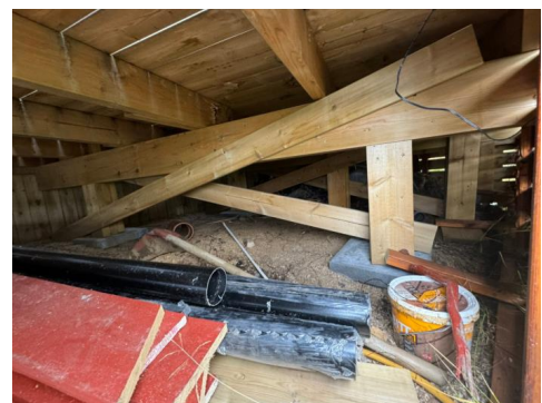
Konstruksjonen under jacuzzi.
