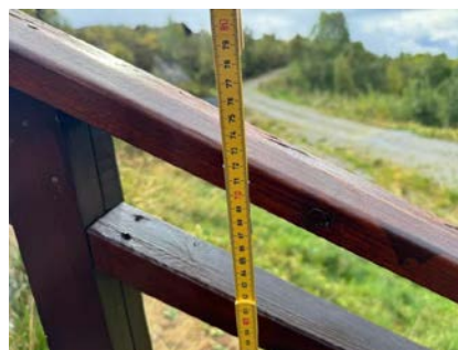
Rekkverkshøyde i trappen.
