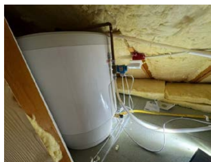
Varmtvannsbereder.
