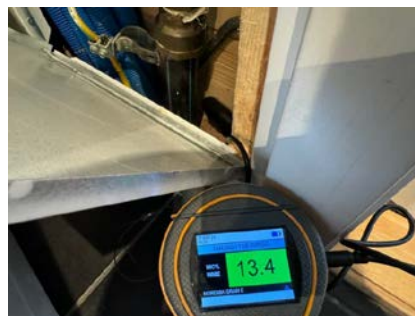
Fuktmåling i inspeksjonsluke.
