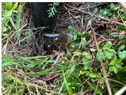
avløp avsluttet over terreng.
