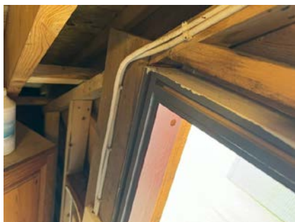
Eksempel på løs ledning.
