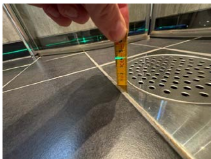
Måling ved sluken.
