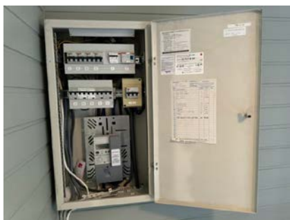
Eksempel på løs ledning.
