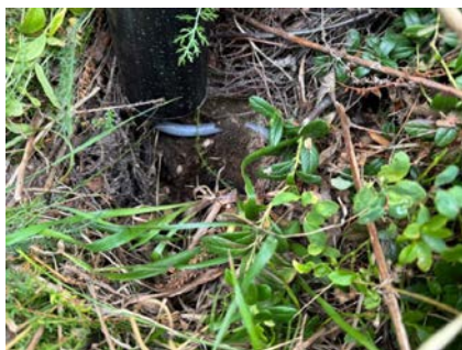
avløp avsluttet over terreng.
