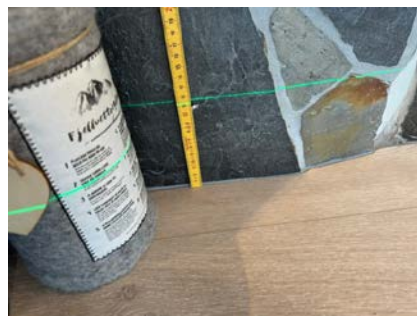
Måling ved pipen.
