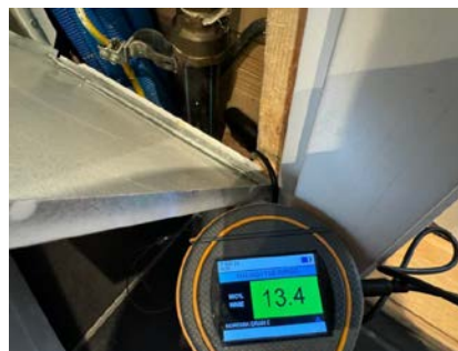
Fuktmåling i inspeksjonsluke.
