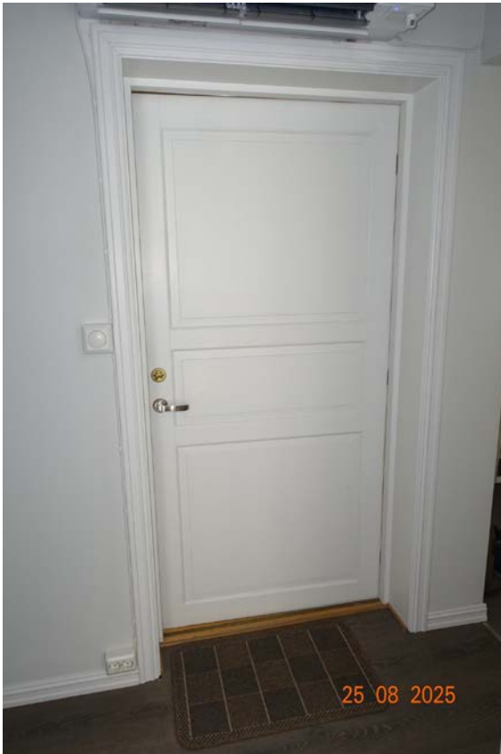
Dør til felles trappegang.
