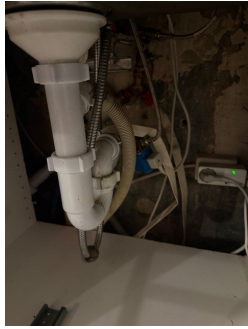
Røropplegg i kjøkkenbenk med Waterguard
