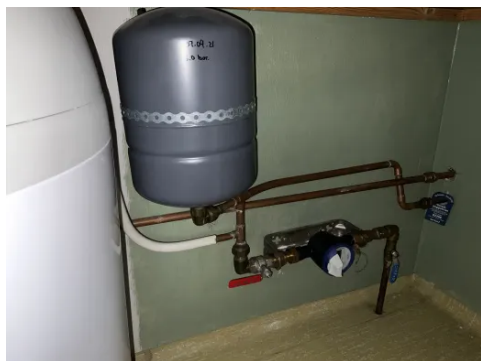
Bilde viser test av stoppekran på befaringsdagen, vann avstengt ved test av kran.
