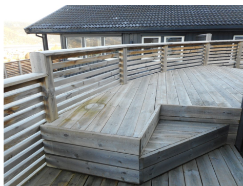
Lavt rekkverk ved garasje.
