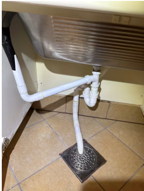
Avløpsrør utslagsvask.
