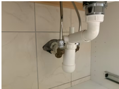
Avløpsrør bad 1. etg
