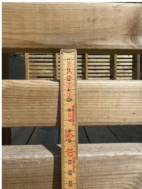
Avstand mellom liggende spiler på terrasse.
