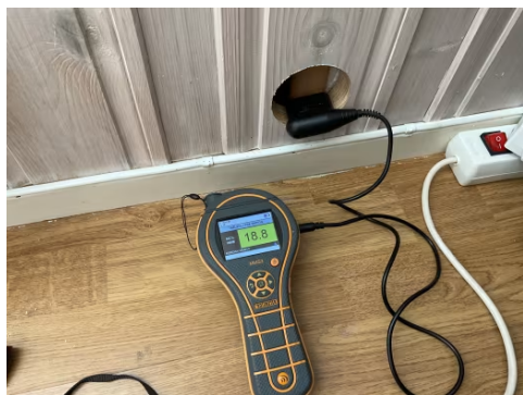
Fuktmåling i vegg mot terreng.
