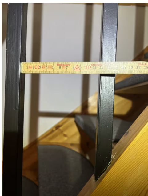
Åpninger i rekkverk.
