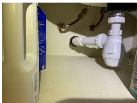
Avløpsrør bad kjeller.
