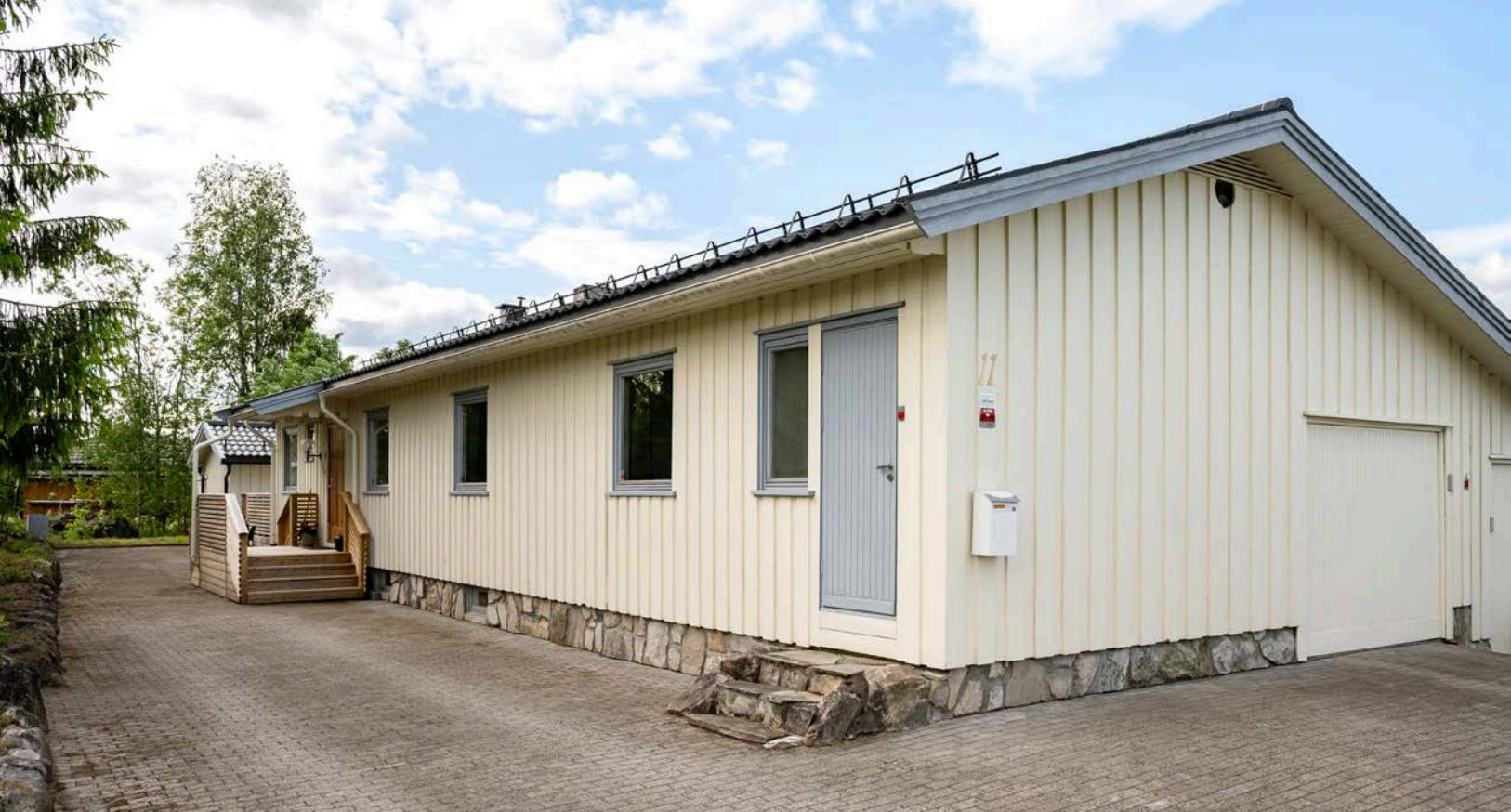
Gårdsplassen er pent opparbeidet med belegningsstein.
