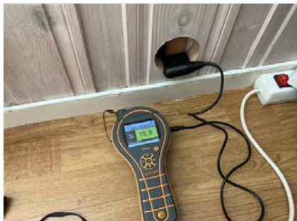
Fuktmåling i vegg mot terreng.
