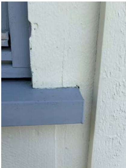
Panel ned til vannbrett.
