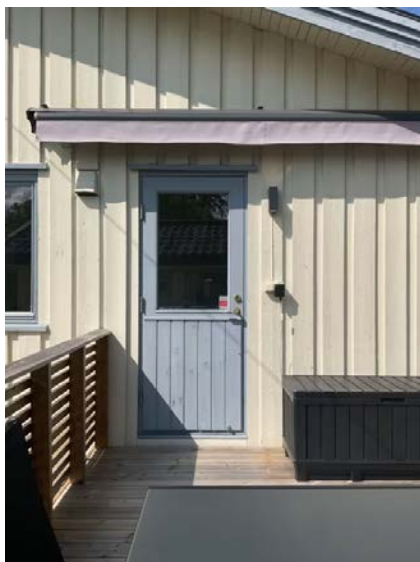
Terrassedør fra kjøkken.
