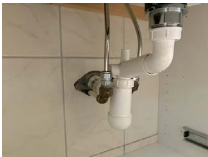
Avløpsrør bad 1. etg
