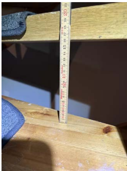
Avstand mellom trinn.
