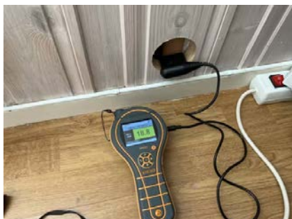
Fuktmåling i vegg mot terreng.
