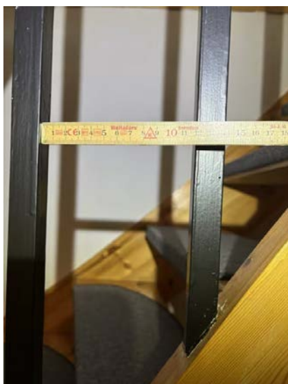
Åpninger i rekkverk.
