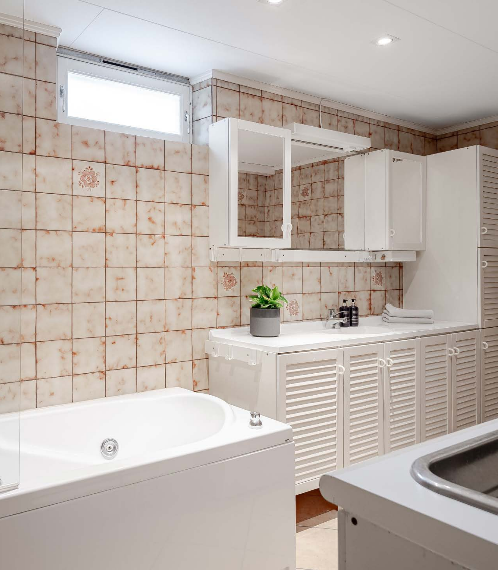
Eldre bad/vaskerom i kjeller med fliser på gulv og vegger, gulvvarme, downlights i himlingen og mekanisk avtrekksvifte.
