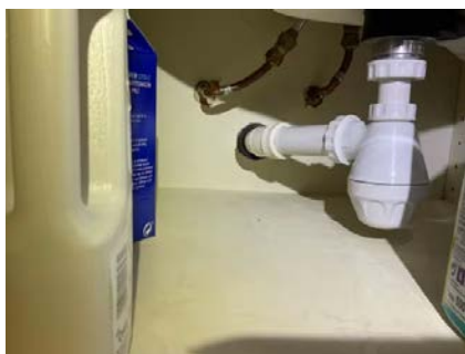
Avløpsrør bad kjeller.
