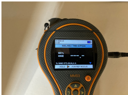
Måling av fukt i treverk. Målinger er foretatt fra inne i benkeskap på kjøkkenet uten å påvise unormale forhold.
