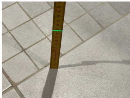
Fallforhold ca. 116 mm overkant gulv ved dusjsone
