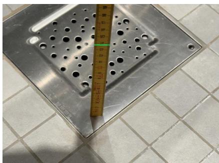
Fallforhold ca. 138 mm topp slukrist i dusjsone
