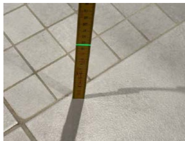
Fallforhold ca. 116 mm overkant gulv ved dusjsone
