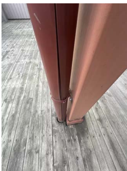
Frostsprengt nedløpsrør fra overliggende terrasse.
