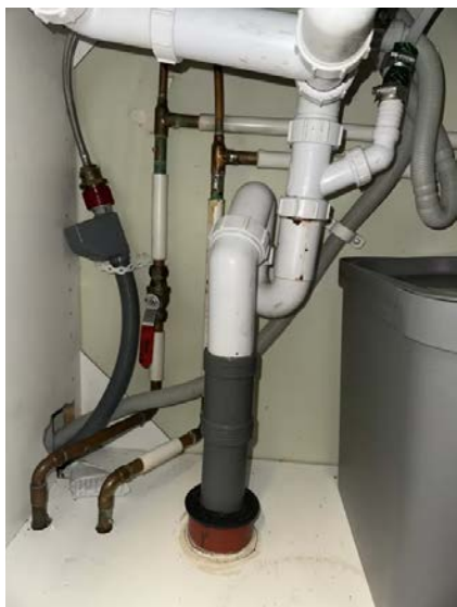
Viser vann og avløpsinstallasjoner under kum.
