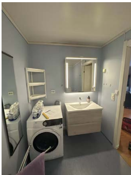
Viser opplegg for vaskemaskin og baderomsinnredning.
