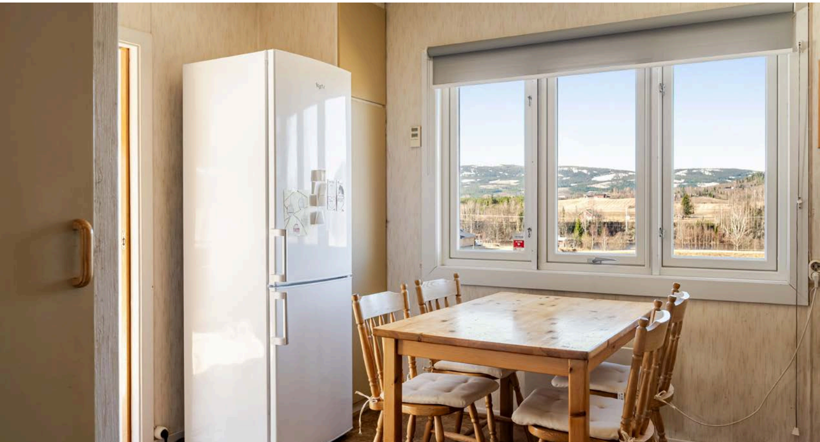
Vinduer i 1. etasje av tre med isolerglass, i hovedsak fra 2017, med unntak av vindu på bad og i trapperom.
