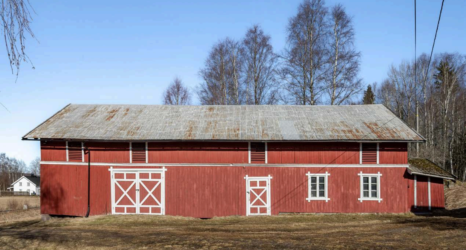
Låven er på ca. 263 m 2 og har vegger av reisverk og tak tekket med metallplater.
