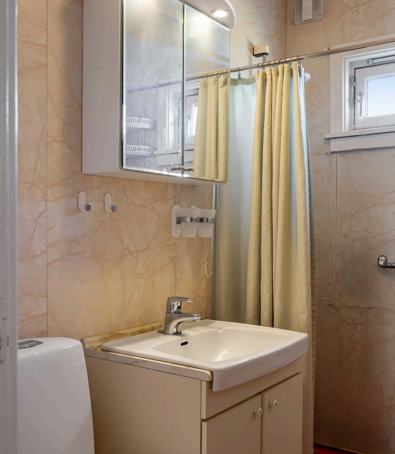
Elektrisk avtrekksvifte i rommet.
