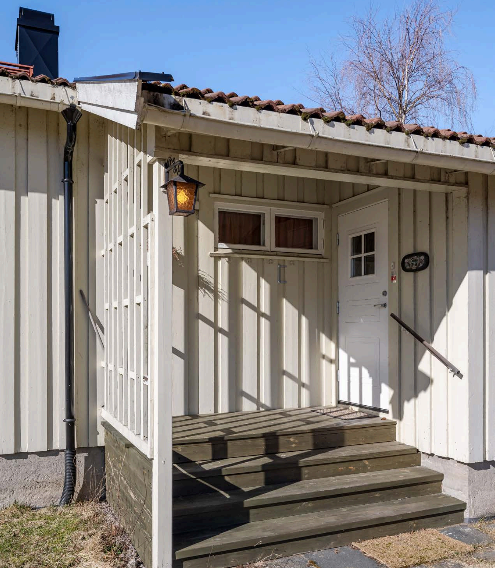
Takoverbygget inngangsparti med trapp av tre.
