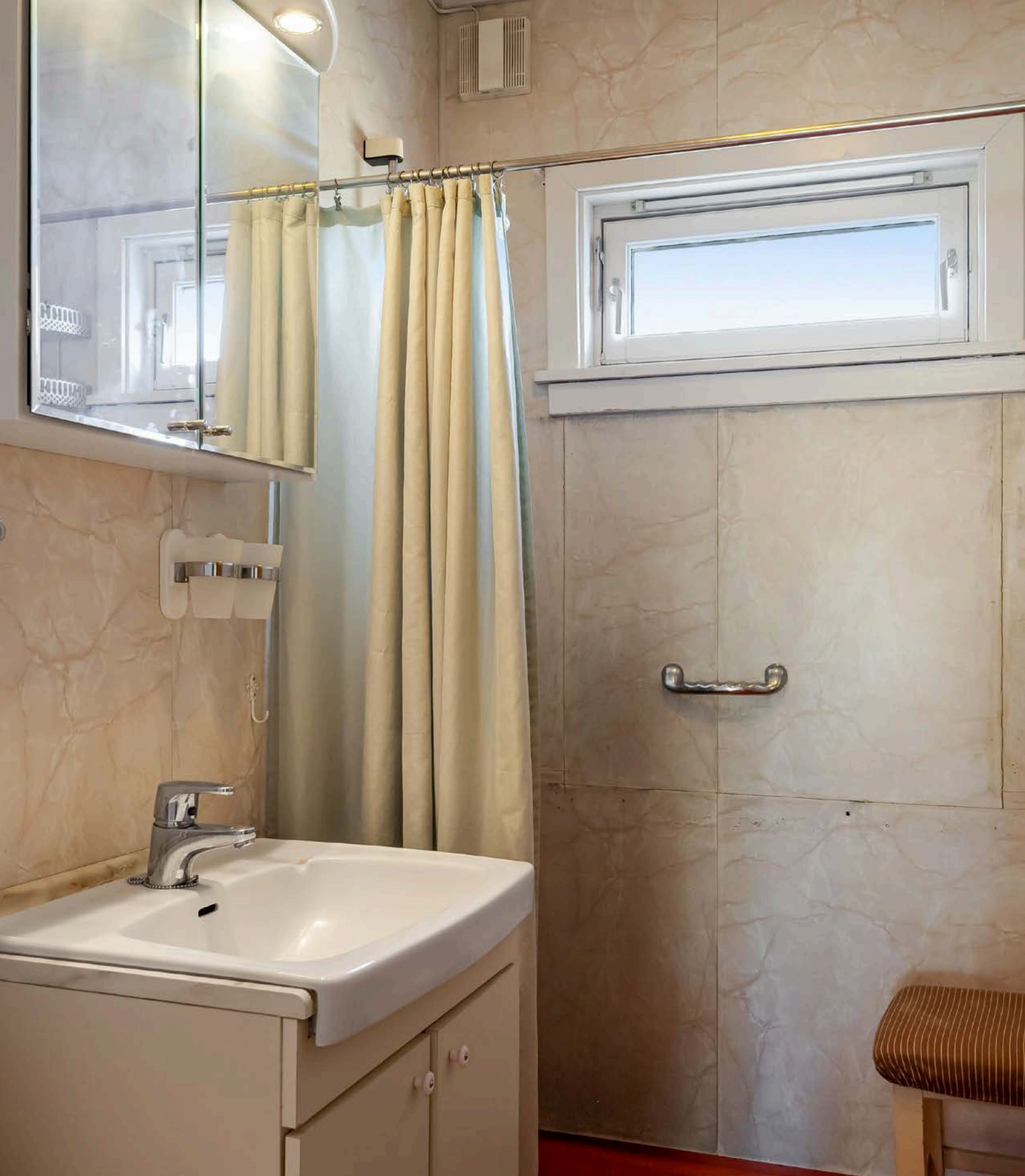
Bad fra byggeår med baderomsplater på veggene og belegg på gulvet.
