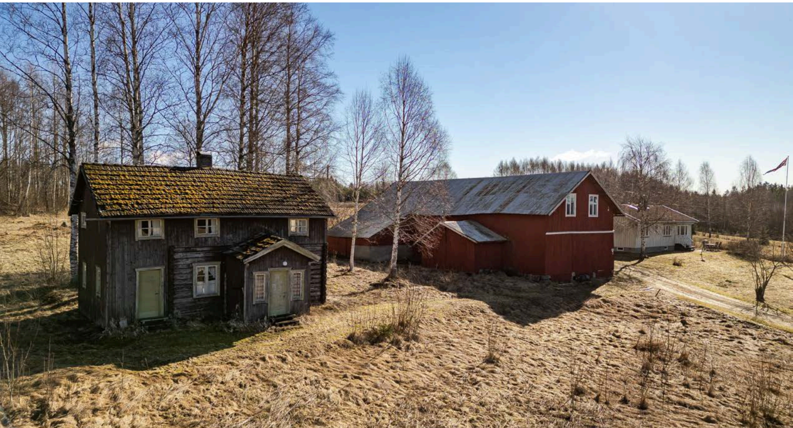
Det står også en tidligere bolig på eiendommen, kondemnabelt bygg.
