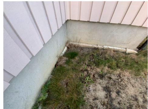
Kontroll av drenering/fuktsikring.
