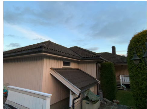
Besiktigelse av taktekke.
