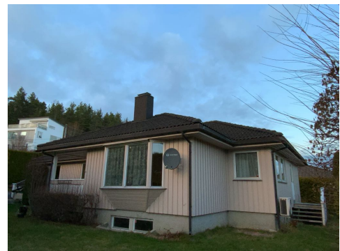
Besiktigelse av taktekke.
