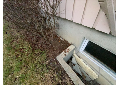
Kontroll av drenering/fuktsikring.
