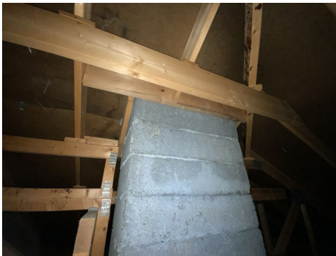
Kontroll rundt pipeløp.
