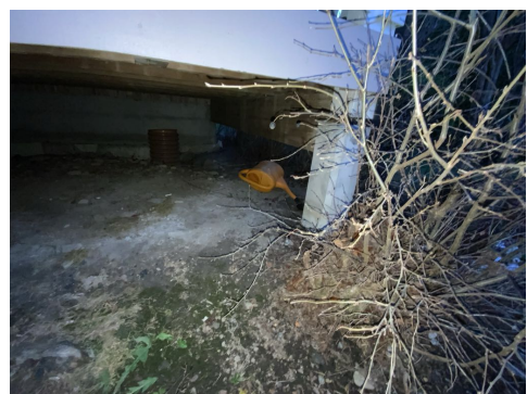
Kontroll av fundament.
