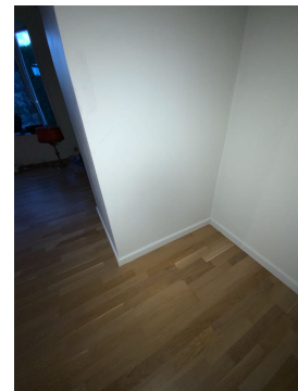
Synlig pipeløp, men ingen ildsted er montert.
