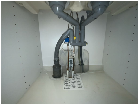
Besiktigelse av røropplegg.
