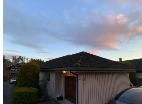
Besiktigelse av taktekke.
