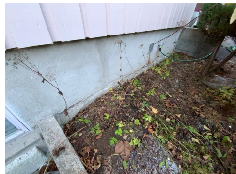
Kontroll av drenering/fuktsikring.
