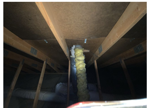
Kontroll rundt rørgjennomføringer.
