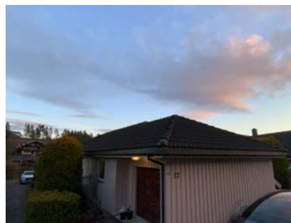
Besiktigelse av taktekke.
