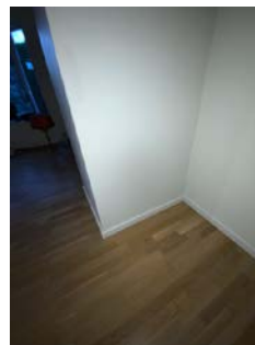
Synlig pipeløp, men ingen ildsted er montert.
