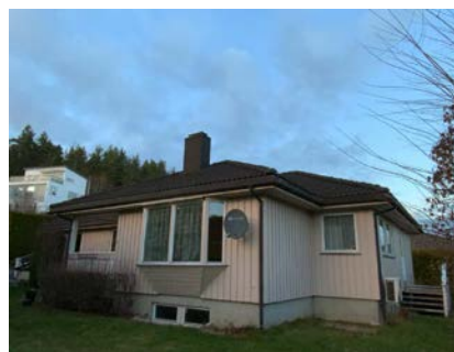
Besiktigelse av taktekke.
