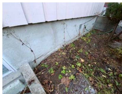
Kontroll av drenering/fuktsikring.
