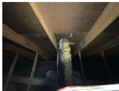
Kontroll rundt rørgjennomføringer.
