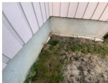
Kontroll av drenering/fuktsikring.
