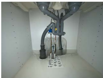
Besiktigelse av røropplegg.
