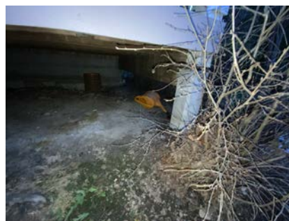
Kontroll av fundament.
