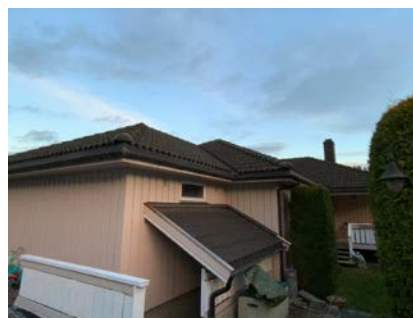
Besiktigelse av taktekke.
