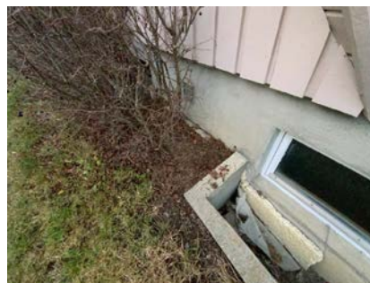
Kontroll av drenering/fuktsikring.
