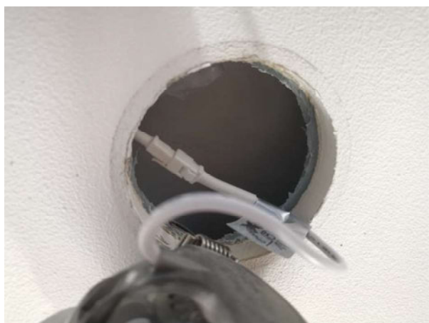
Bilde 3 og 4: Ett lag gips i himling i takkonstruksjonen perforert av downlights og utette og dårlige tilslutninger mellom panel og vegg som gir rask tilgang for brann til bjelkelaget.
