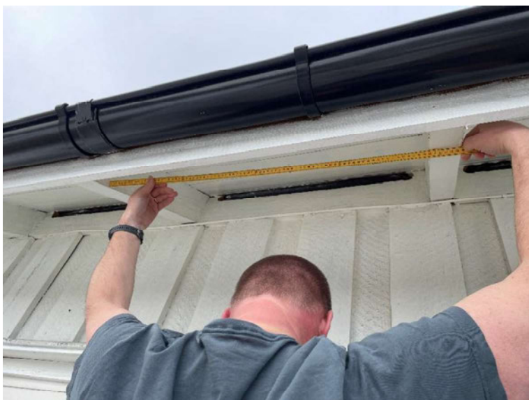
Figur 5: Bildet viser at sperrene har en senteravstand på ca 860mm.
