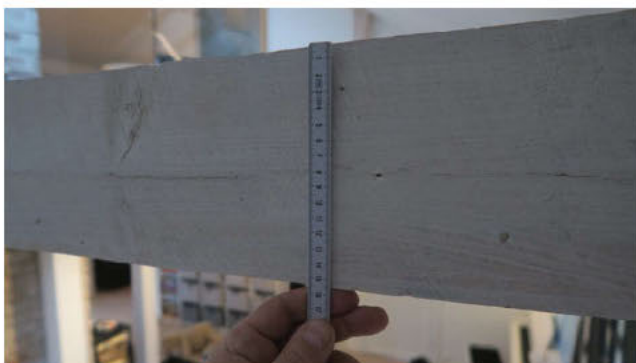
Måling av høyde på gulvbjelker mot loft.
