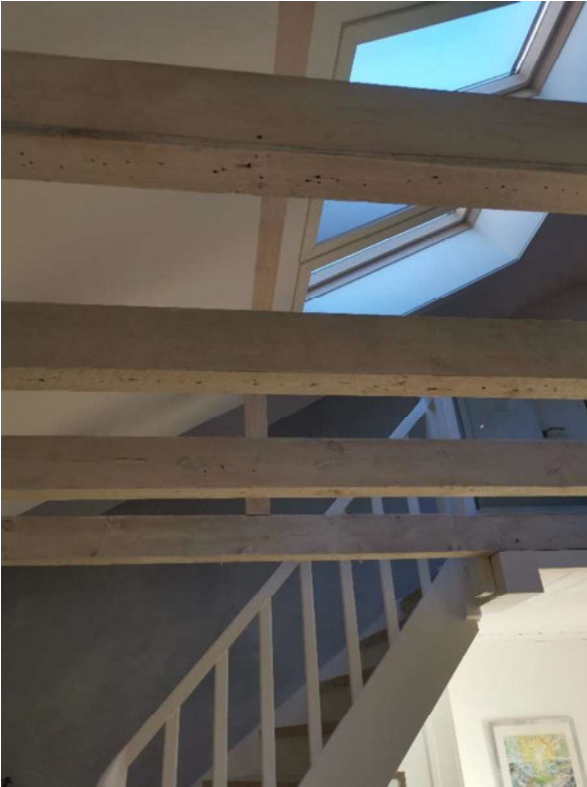
Bilde 5 og 6: Ubeskyttet bjelkelag mellom 2. etasje og loftsplan. Ubeskyttede stålbjelker i kjellerplan.
