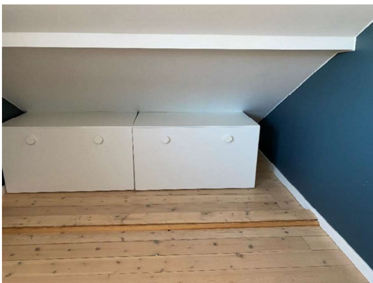
Figur 3: Bildet viser loftsrom mot nord hvor knevegg mot øst er fjernet, kun topp- og bunnsvill står igjen.
