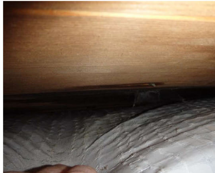
Bilde nr. 18 Himling over soverom nord. Fra kneloft. Luftespalte er noe for liten. Kondensfukt undertak sees.
