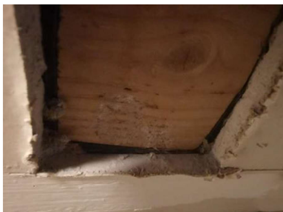
Bilde 2: Det er lagt ett lag normalgips i himling i kjeller opp mot leilighet (seksjon 1).
