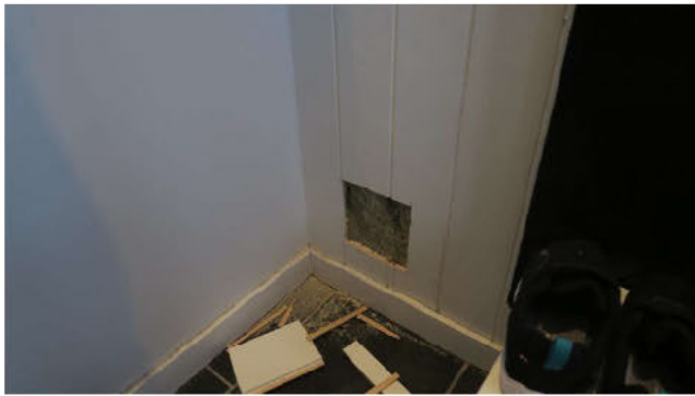
Det ble åpnet i vegg i entre.
