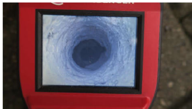
Ingen tegn til isolering i grunnmuren.
