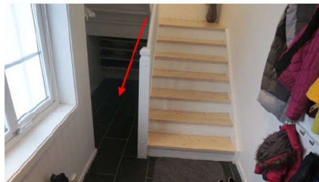
Trapp må bygges ny. Pil viser gulvet der det må tas hull ned til kjeller.
