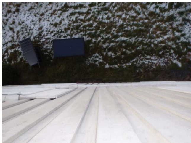
Bilde nr. 6 Vindu soverom 3. etg. mot Syd Ut for vindu til venstre. Her er i god mulighet for oppføring av brannstige med bøyle mellom vinduer nedenfor.
