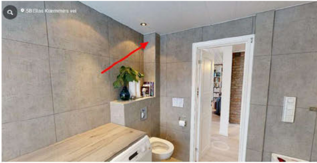
Kasse for avløpslufting.
