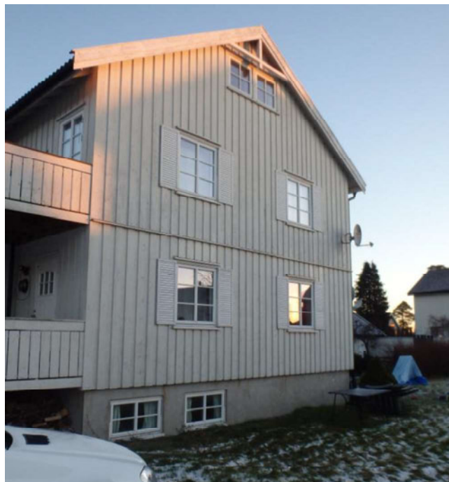
Bilde nr. 10 Fasade mot Syd. God plass for føring av sammenleggbar brannstige med bøyle. Avstand til vinduer vil bli mindre enn 2 meter.
