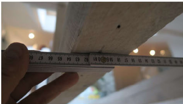
Avstand mellom gulvbjelker mot loft.
