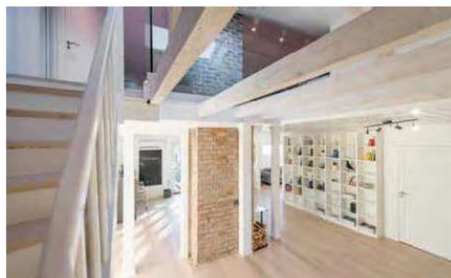
Senere ser vi at bjelkelaget åpnes og bjelkene eksponeres.
