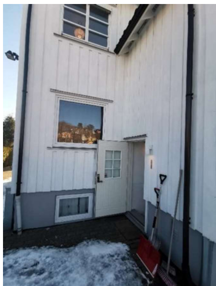
Bilde 1 Vinduer i seksjon 1 tett på ytterdør fra kjellerdel.
