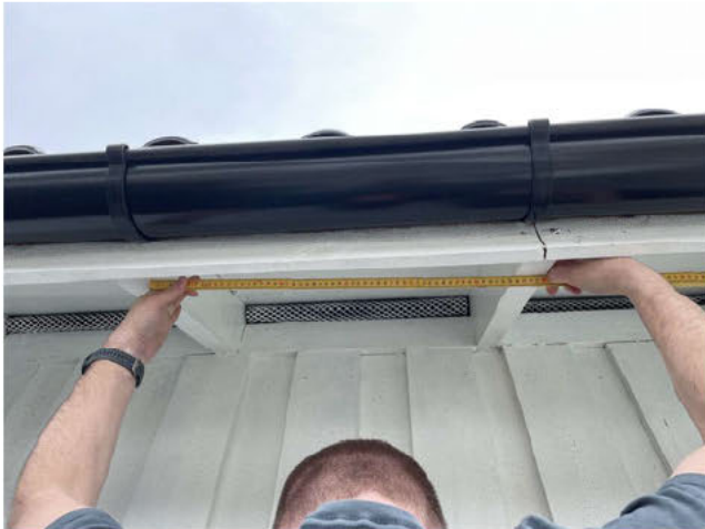
Måling av sperrer på tilbygget del har en senteravstand på ca 60 cm.
