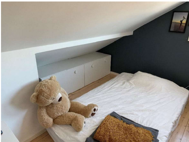
Figur 2: Bildet viser loftsrom mot nord hvor knevegg mot vest er fjernet, kun topp- og bunnsvill står igjen.
