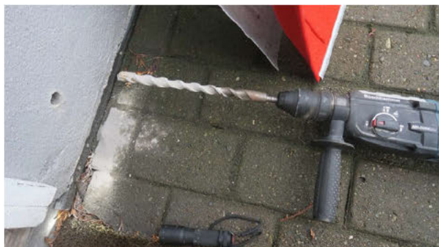
Det ble boret på et sted til for å verifisere at det ikke var isoblokk andre steder.
