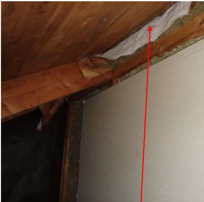
Bilde nr. 19 Kneloft bak trapp / gang. Også her noe for liten luftespalte.
