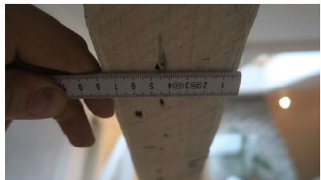
Bredde på gulvbjelker mot loft.
