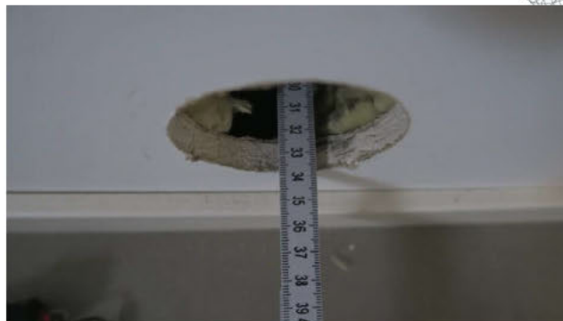
Til bunn av hull er det 32,5 cm. Det er boret 21 cm inn i grunnmur.
