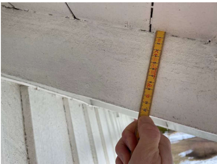
Figur 7: Bildet viser at taksperrere har en høyde på ca 125mm.
