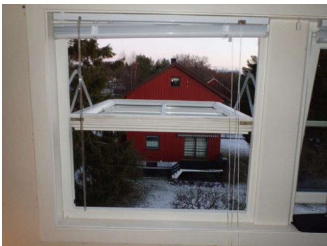
Bilde nr. 3 Vindu soverom 3. etg. mot Nord Vinduer av type H-vindu patent. Målene tilfredsstill kravene for rømning.
