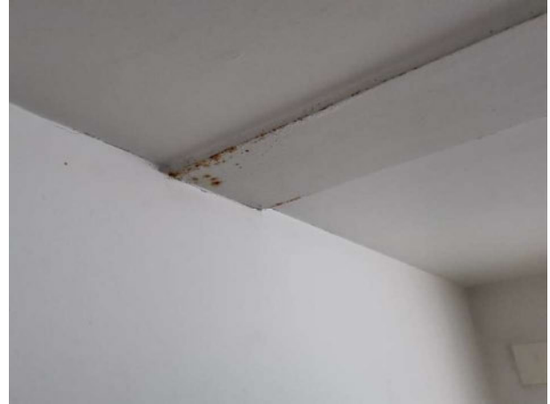
Bilde 5 og 6: Ubeskyttet bjelkelag mellom 2. etasje og loftsplan. Ubeskyttede stålbjelker i kjellerplan.
