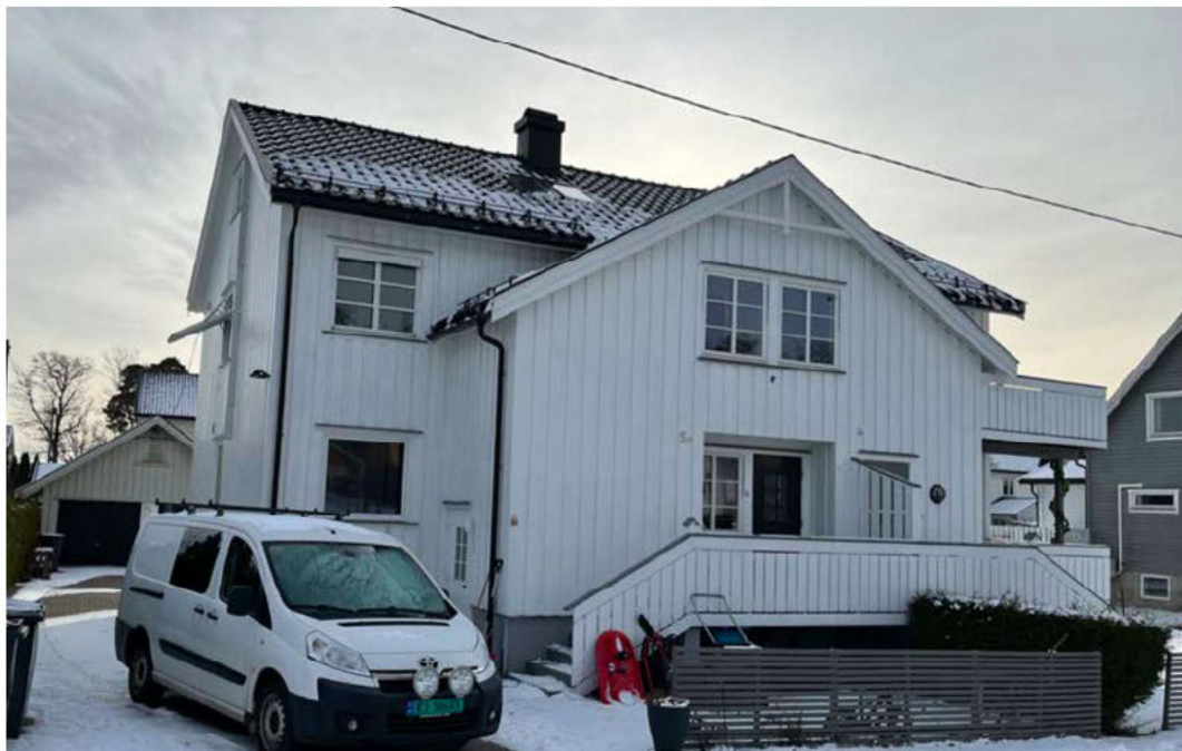
Bilde er tatt Elias Kræmmers vei, omtalte seksjon er 2 etasje, loft del av utbygg 1 etasje samt del av kjeller
