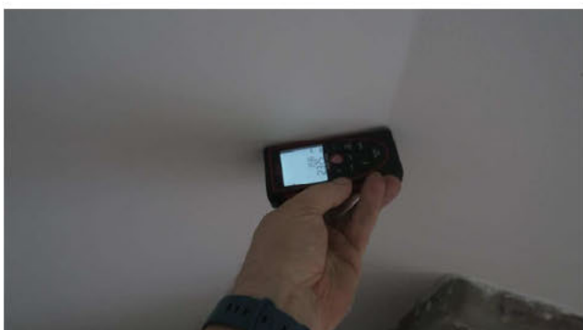
Måling av skrå himling.
