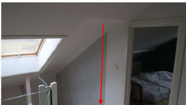
Måling av takhøyde ved trapp.
