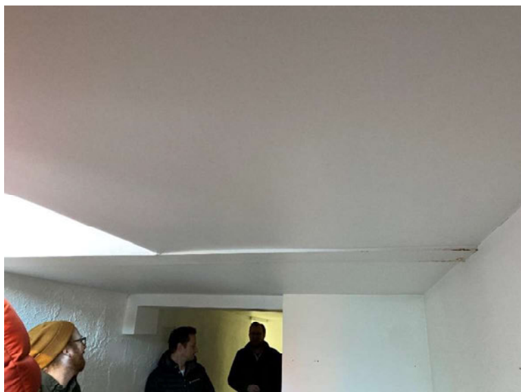
Figur 12: Bildet viser bjelken i taket i kjeller. Den er så vidt synlig da kun undersiden av bjelken stikker ca 10mm ned fra himlingen.
