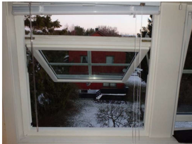
Bilde nr. 2 Vindu soverom 3. etg. mot Nord Vinduer av type H-vindu patent. Målene tilfredsstill kravene for rømning.
