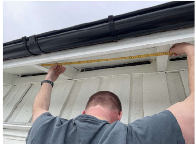
Opprinnelig del har en senteravstand på sperrene på 86 cm.
