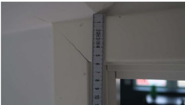
Dørhøyder kan ikke økes uten å heve taket vesentlig. Dette er ikke gjennomførbart.
