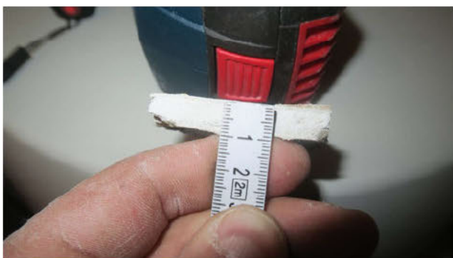
9,5 mm gips i himling på teknisk rom.
