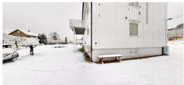
Flatt og stedvis motfall på terreng. Det skal være 1:50 fall på terreng de første 3 meter fra grunnmur. Punktet er ikke beskrevet i tilstandsrapport.
