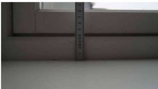
Karmen er ca 4 cm ekstra og utgjør total 105 cm. Ved pigging av gulv vil denne høyde øke ytterligere.
