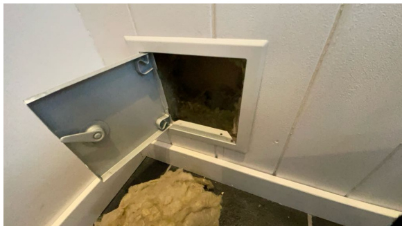
ikke brannvegg mellom leiligheter i 1. etasje.
