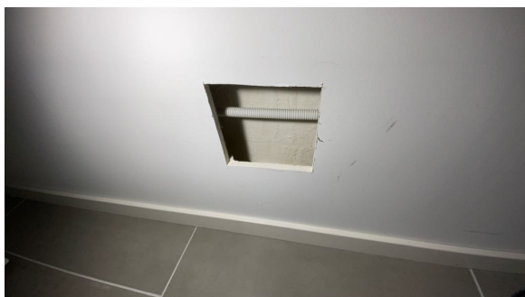
ikke brannvegg mellom leiligheter i 1. etasje.
