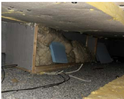
Kryperom under leiligheten med etterisolering av vannrør.
