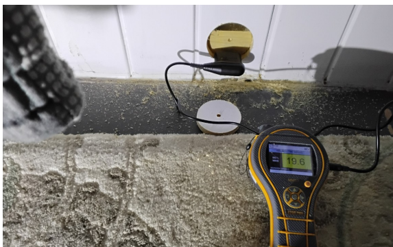
Fuktmåling i trelekt/spikerslag.
