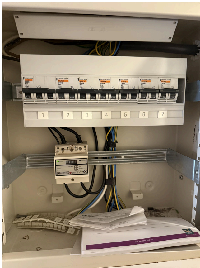
EL-skap sokkelleilighet montert i gang i underetasjen
