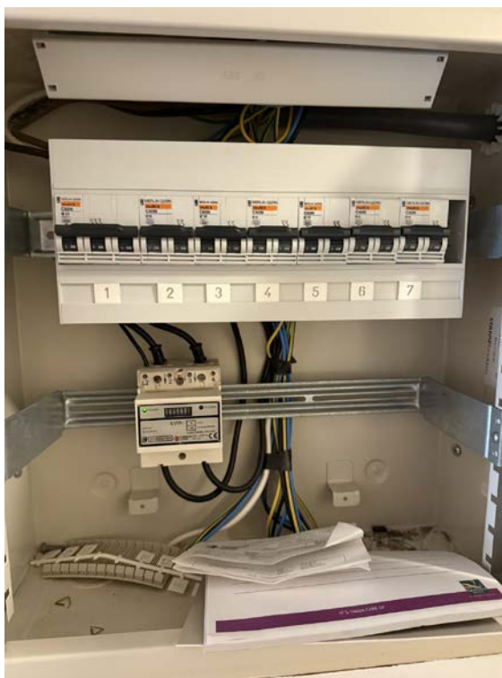
EL-skap sokkelleilighet montert i gang i underetasjen
