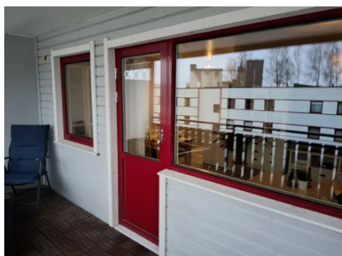
Leiligheten har vinduer og balkongdør med tre-lags glass.
