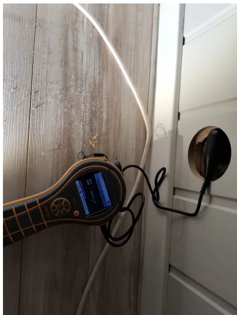
Bilde fra fuktmåling i veggkonstruksjon tilstøtende dusjsjonen.
