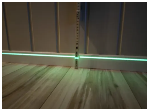
Etasjeskillet er kontrollert med nivelleringslaser.
