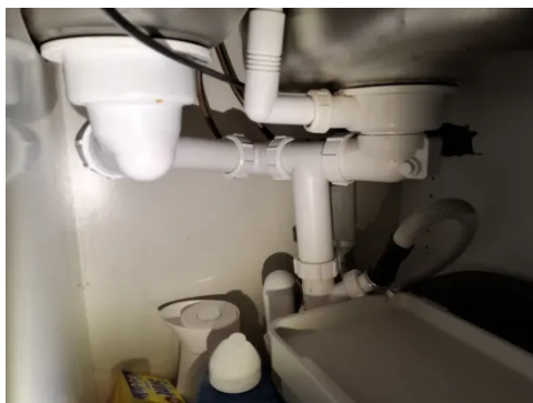
Leiligheten har synlige avløpsrør av plast.
