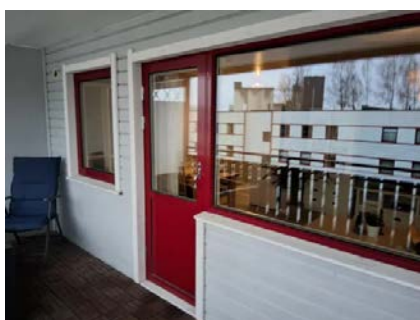
Leiligheten har vinduer og balkongdør med tre-lags glass.
